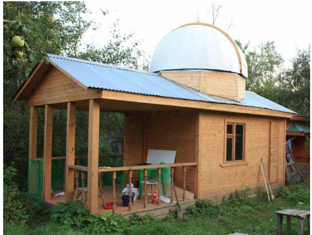
Виктор Майоров. Астрокупол над хозяйственным блоком. Диаметр купола 3 м.
